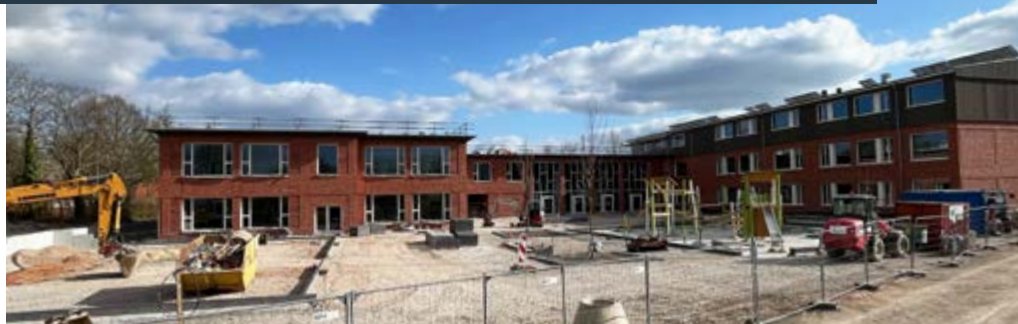
Endspurt im Bau der neuen Grundschule
